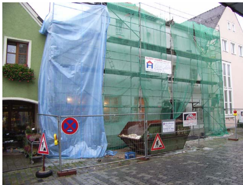
Letzte Arbeiten im Oktober 2007
