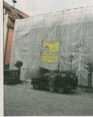
Der Marktplatz 25 wird saniert.
