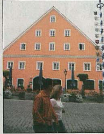
Der Huberbräu ist top saniert.
