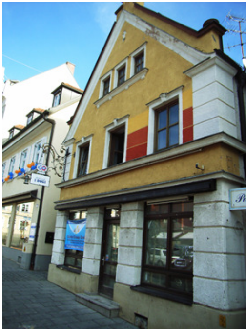
Das Gebäude Hauptstraße 32 wird zur Zeit grundsanziert.
