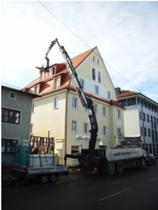
Das Wohngebäude Dachauerstraße 12 wird mit neuen Balkonen und Gauben aufgerüstet.
